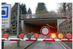
Der Engelberttunnel wird gesperrt.
